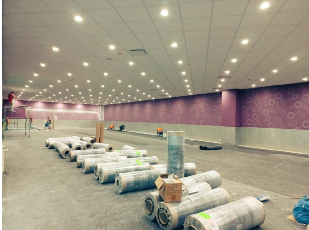
Colocación de papel tapiz, vinyl & piso de goma
