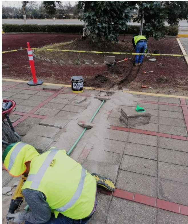
Trabajos de obra civil en Grupo Modelo
