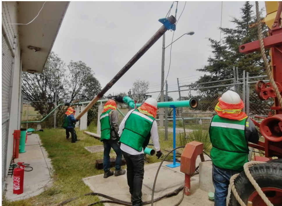
Trabajos de izajes en tubería de 180 mt. De profundidad
