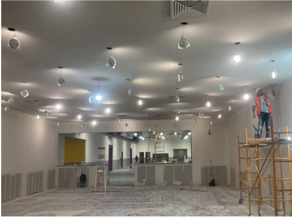
Trabajos de pintura a detalle
