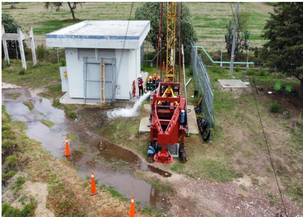
Imagen aérea de mantenimiento a pozo.
