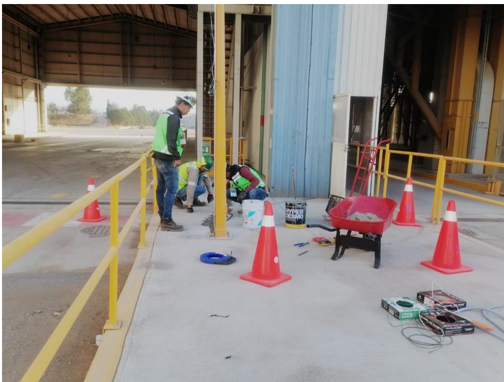
Ranuración en piso y para cableado y resanado
