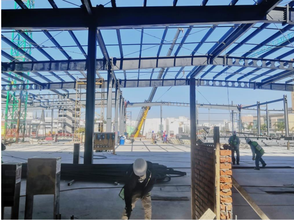
Supervisión de trabajos de obra civil y de estructuras metálicas
