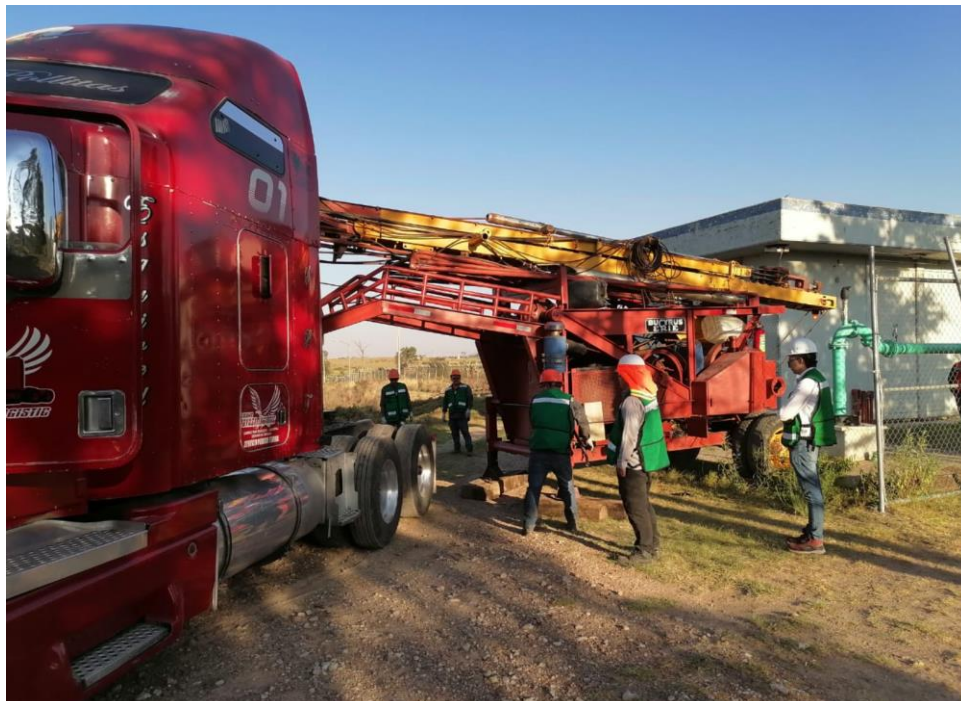
Ingreso de maquinaria pesada para mantenimiento a pozo de agua.
