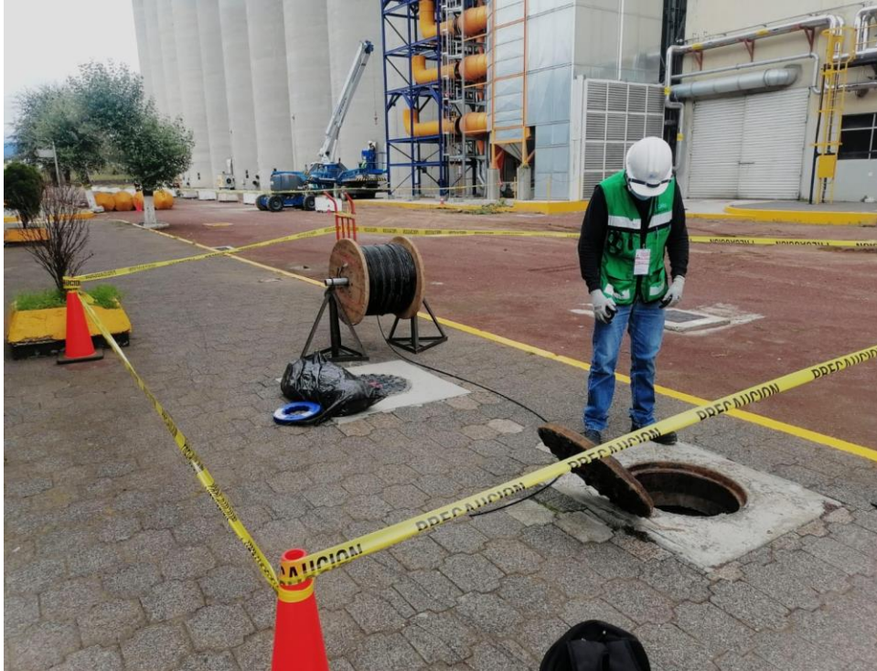
Supervisión y desarrollo de trabajos de fibra óptica.
