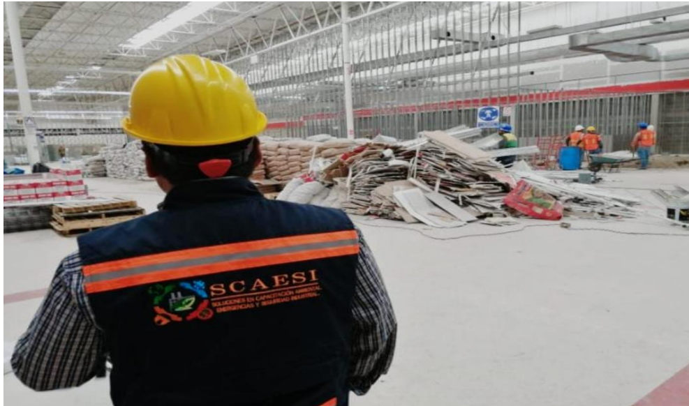
Supervisión de construcción de local comercial.
