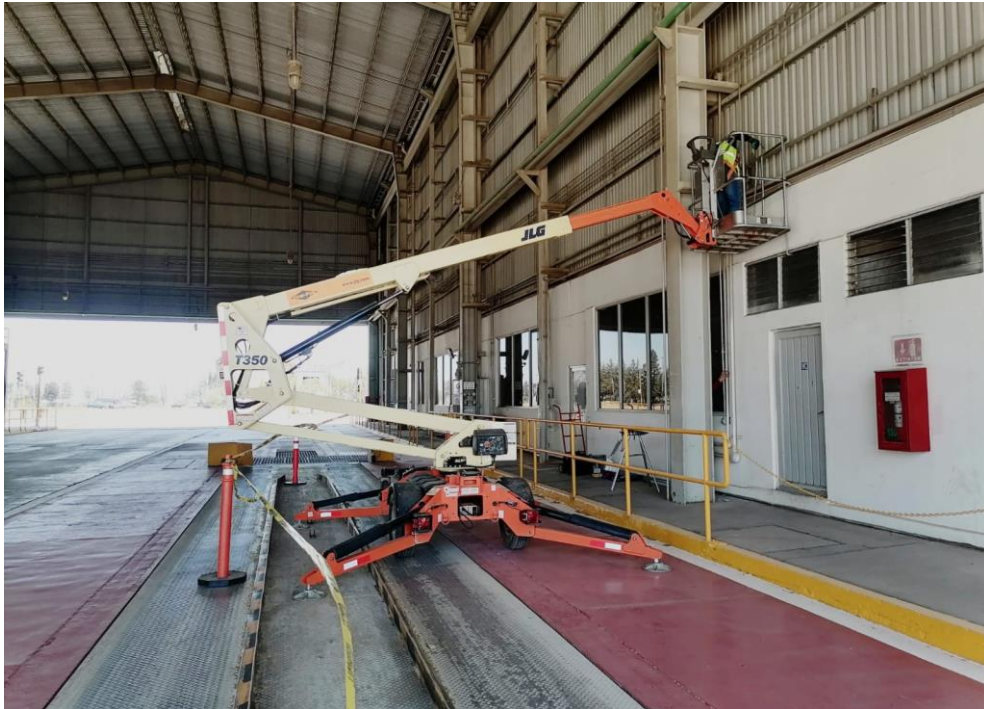
Trabajos en alturas, colocación de antenas de internet Satelital STARLINK
