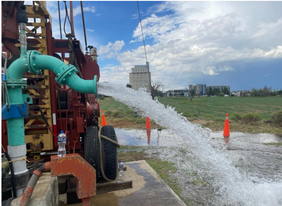
Supervisión y mantenimiento a Pozo de Agua en Grupo Modelo
