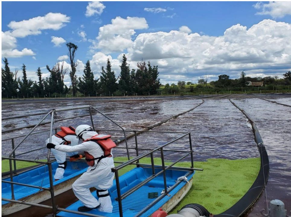
Trabajos de mantenimiento a difusores en lagunas. Grupo Modelo
